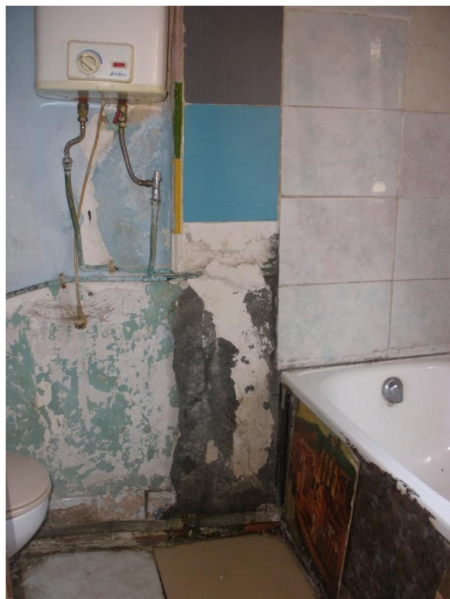
vivienda en planta 2ª (baño 2)
