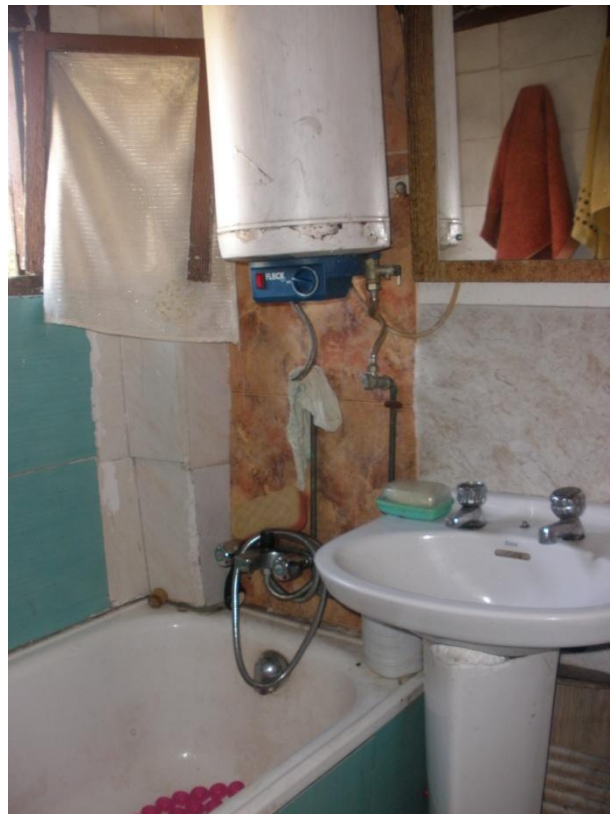
vivienda en planta 2ª (baño 1)
