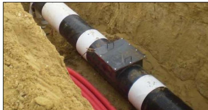
Figura 6. Registro de tubería en zanja
