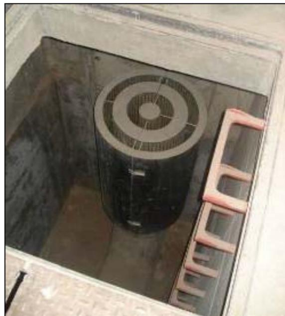
Figura 16. Válvula de aire con silenciador en arqueta
