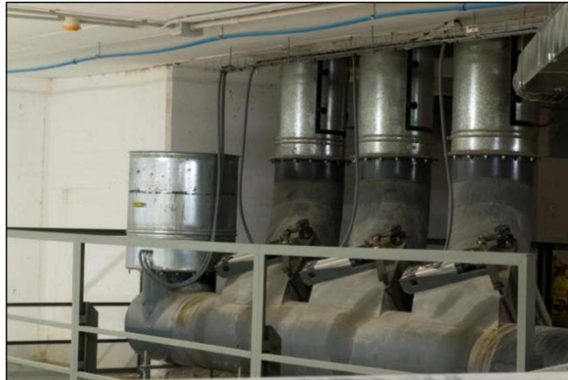
Figura 15. Válvula de residuos inclinada en posición inclinada
