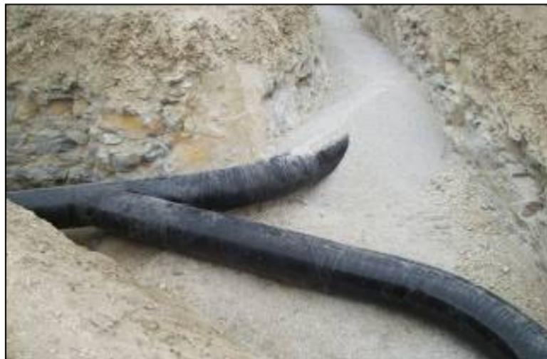
Figura 4. Unión de dos ramales mediante entronque
