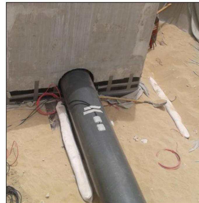
Figura 22. Ejemplo instalación de ánodo en arqueta de registro
