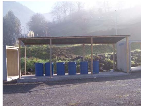
Punto limpio en construcción
