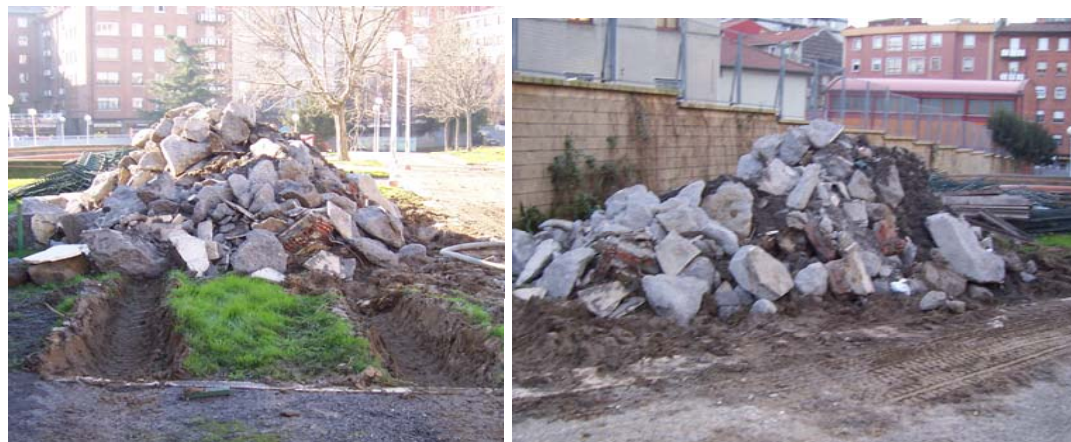
Acopio de residuos de construcción y demolición
