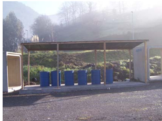
Punto limpio en construcción
