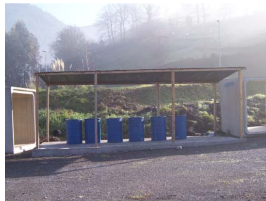
Punto limpio en construcción
