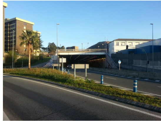
Salida túneles Ibarrekolanda
