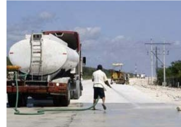
Mantenimiento de la limpieza en viales
