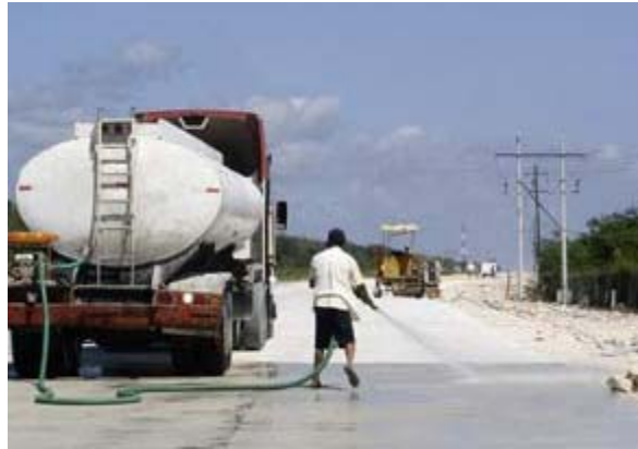
Mantenimiento de la limpieza en viales
