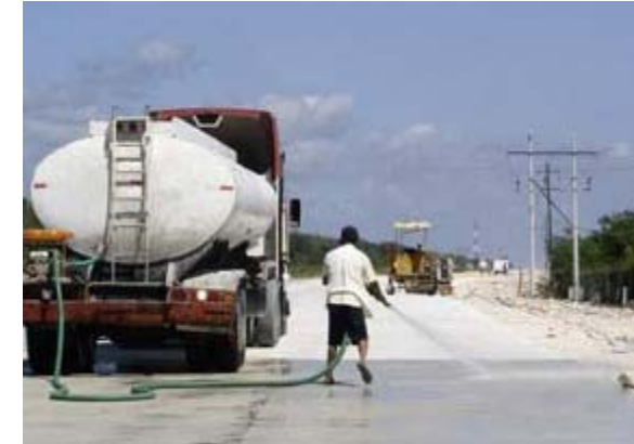
Mantenimiento de la limpieza en viales
