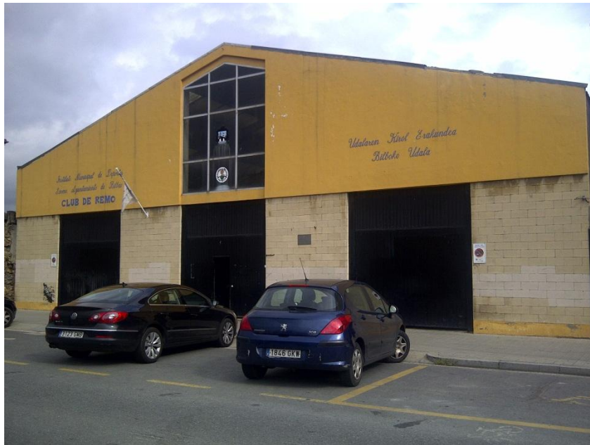
Vista de la fachada principal
