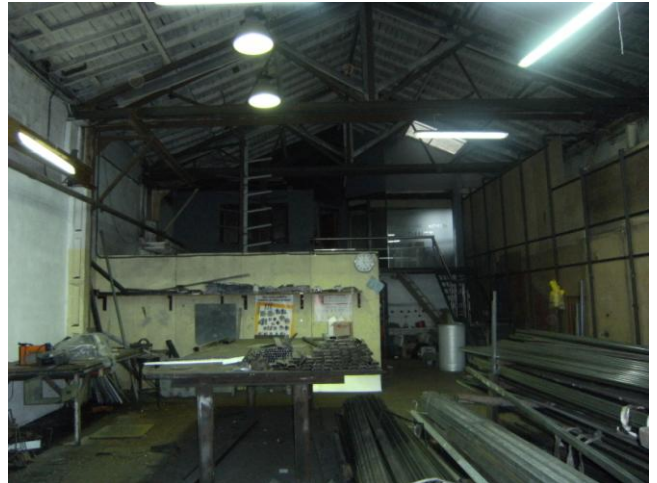
Interior de la nave W
