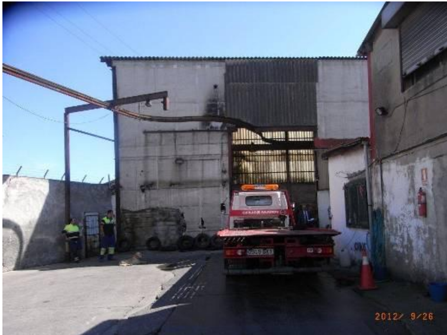
Vista de la fachada principal
