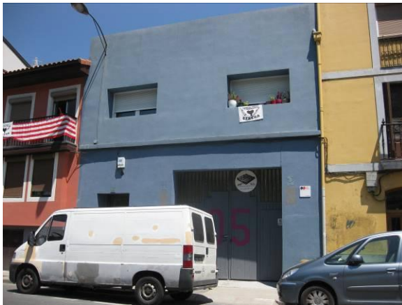
Acceso al edificio 1 (planta baja)
