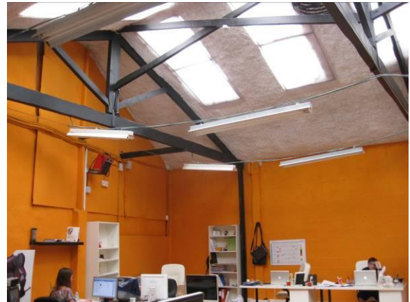
Interior del edificio 2
