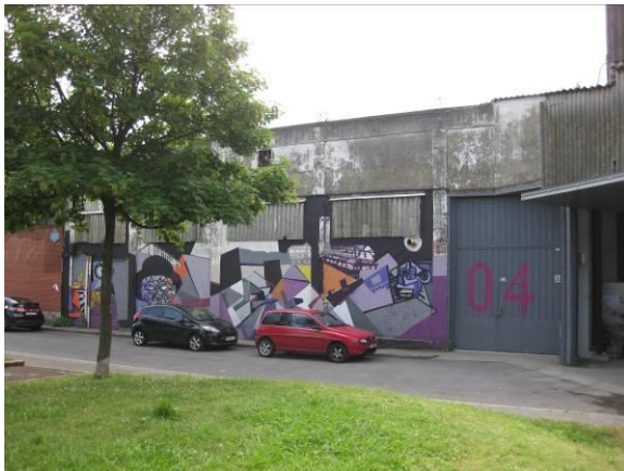
Fachada exterior edificio 6
