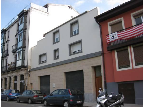
Acceso por la calle Ribera de Deusto
