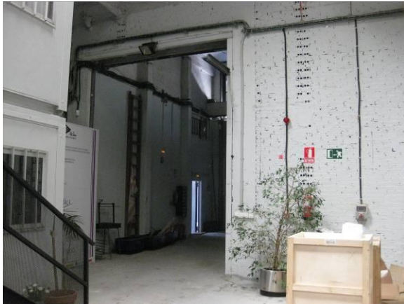
Acceso desde pasillo por edificio 6
