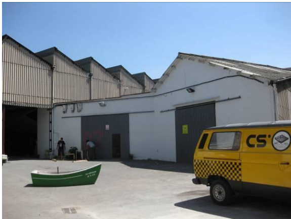
Edificio 9, cubierta en dientes de sierra
