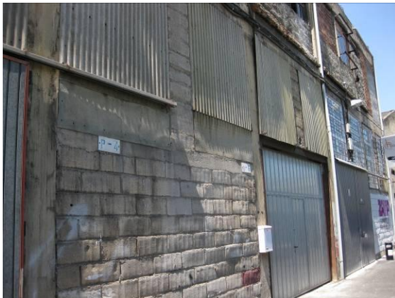
Accesos al edificio 8
