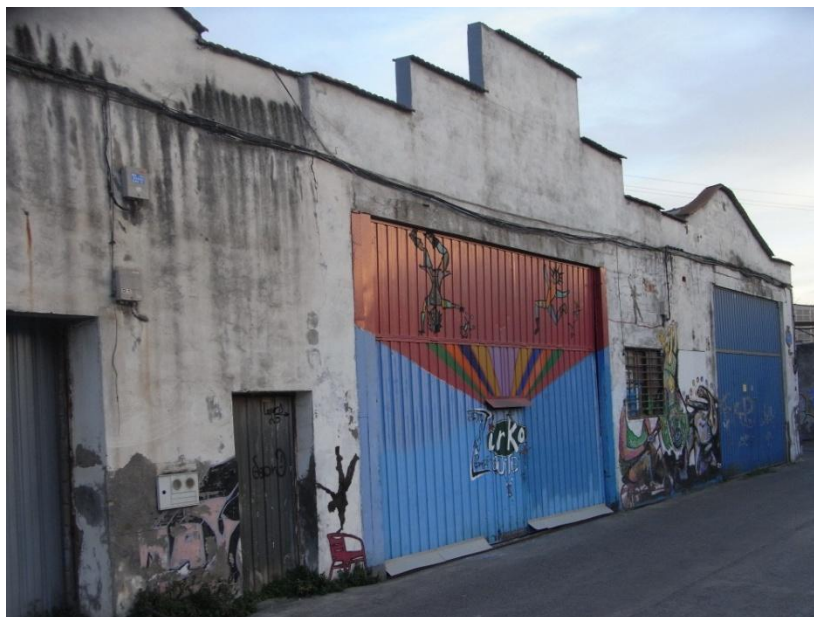
Vista de la fachada principal
