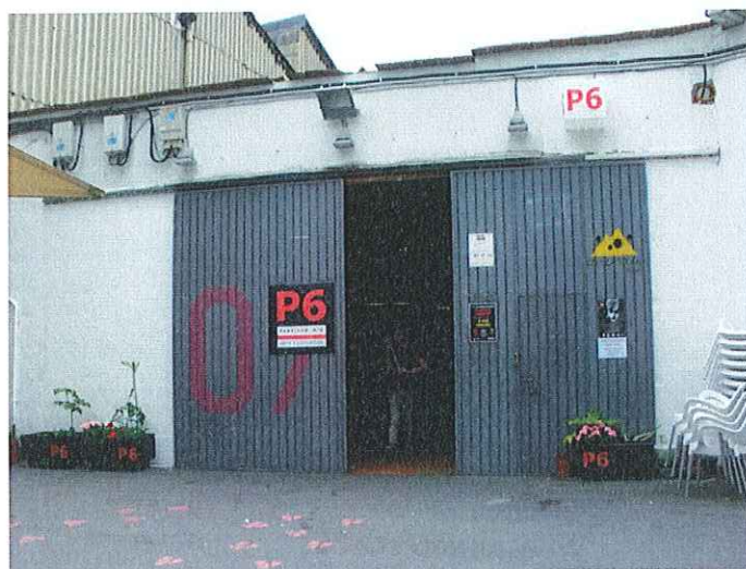
EXTERIOR NAVE 5ª
