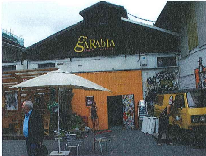
EXTERIOR NAVE 2ª (parcela 39)
