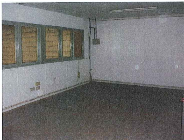
INTERIOR NAVE 8ª ( ENTREPLANTA – OFICINA)
