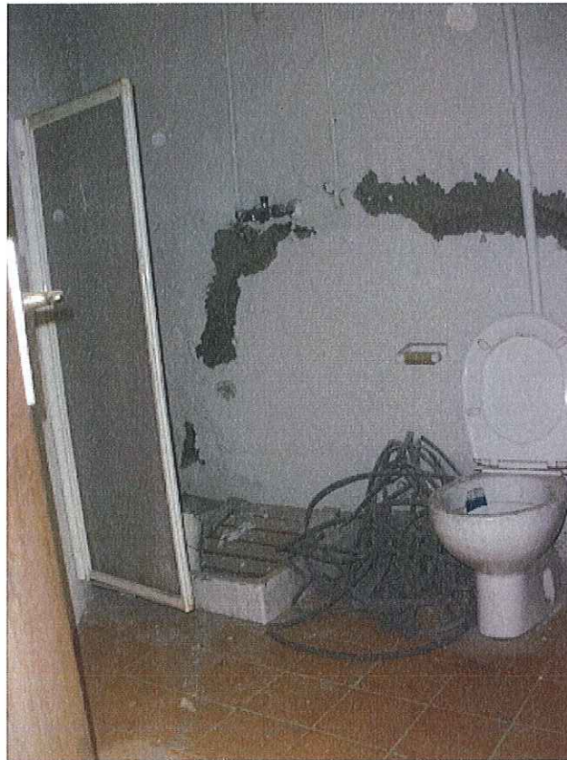
INTERIOR NAVE 11ª (ASEO)
