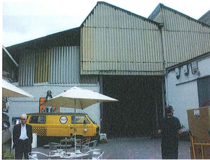
EXTERIOR NAVE 3ª (DESDE PATIO INTERIOR)
