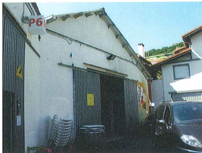
EXTERIOR NAVE 6ª
