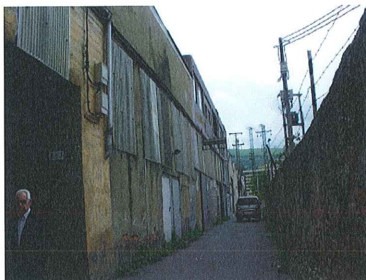
EXTERIOR CAMINO DE LA FUENTE - NAVE 8ª
