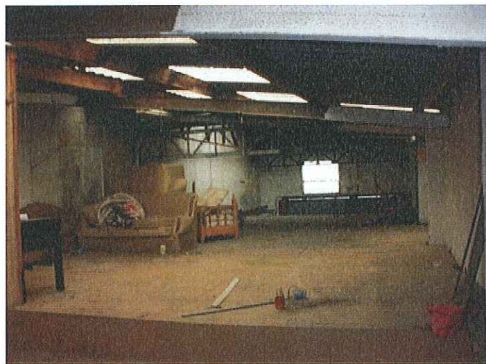
INTERIOR NAVE 9ª (ENTREPLANTA – ALMACEN)
