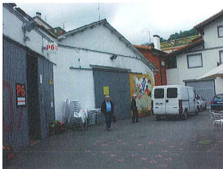
EXTERIOR NAVE 6ª (acceso desde patio interior)
