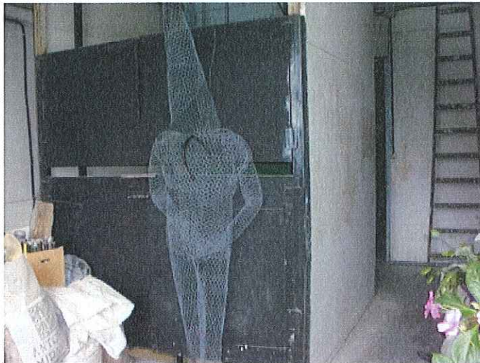
INTERIOR LOCAL INDUSTRIAL EN PLANTA 1ª (ZONA DE MONTACARGAS)
