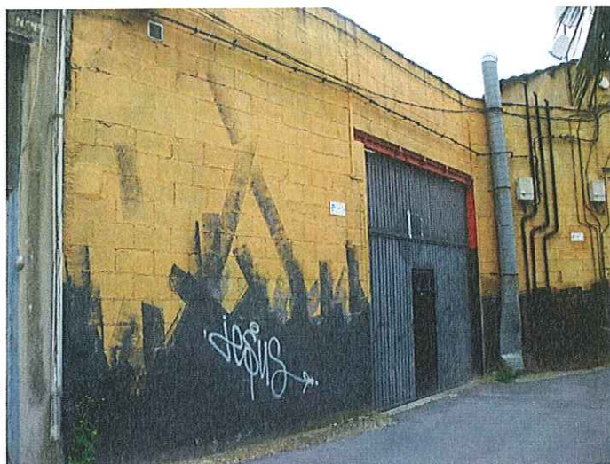
EXTERIOR NAVE 11ª
