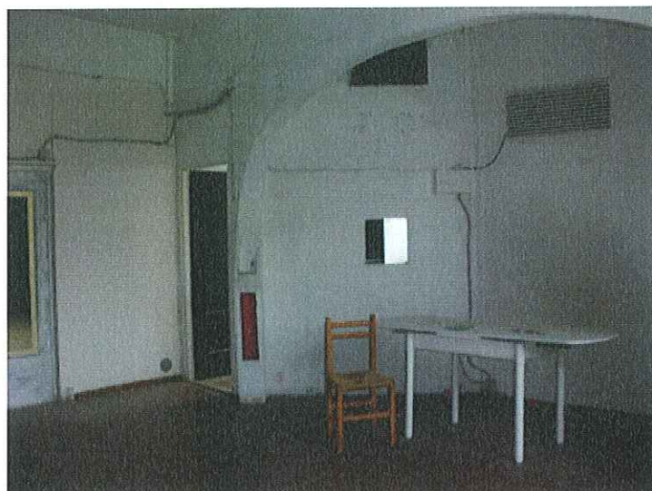
INTERIOR LOCAL INDUSTRIAL EN PLANTA 1ª
