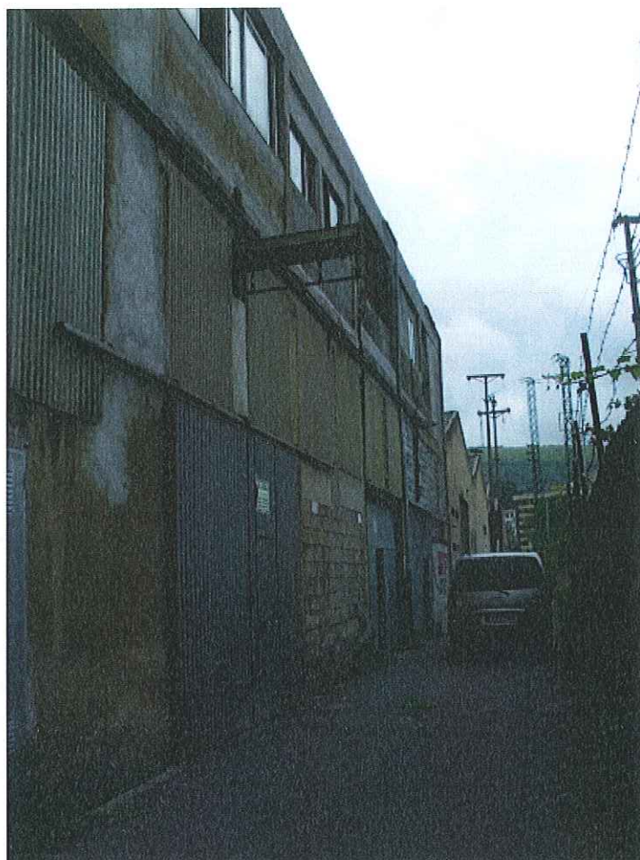
EXTERIOR NAVE 8ª
