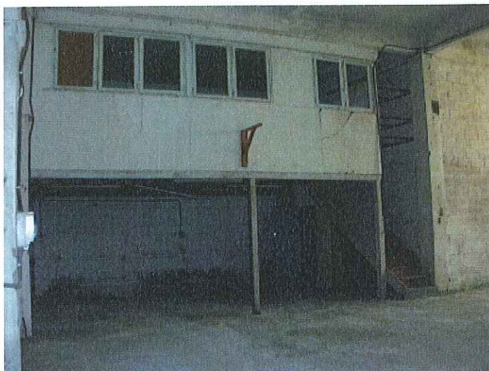
INTERIOR NAVE 8ª (VISTA DE LA ENTREPLANTA)
