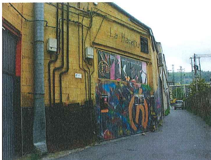
EXTERIOR NAVE 10ª
