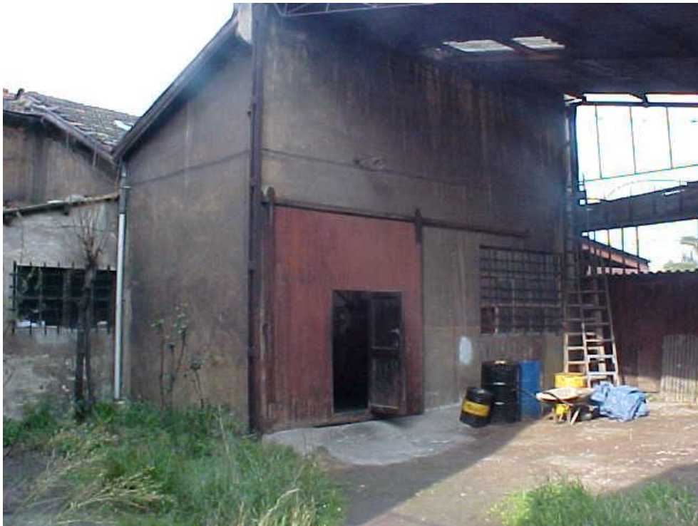
Vista de la fachada principal
