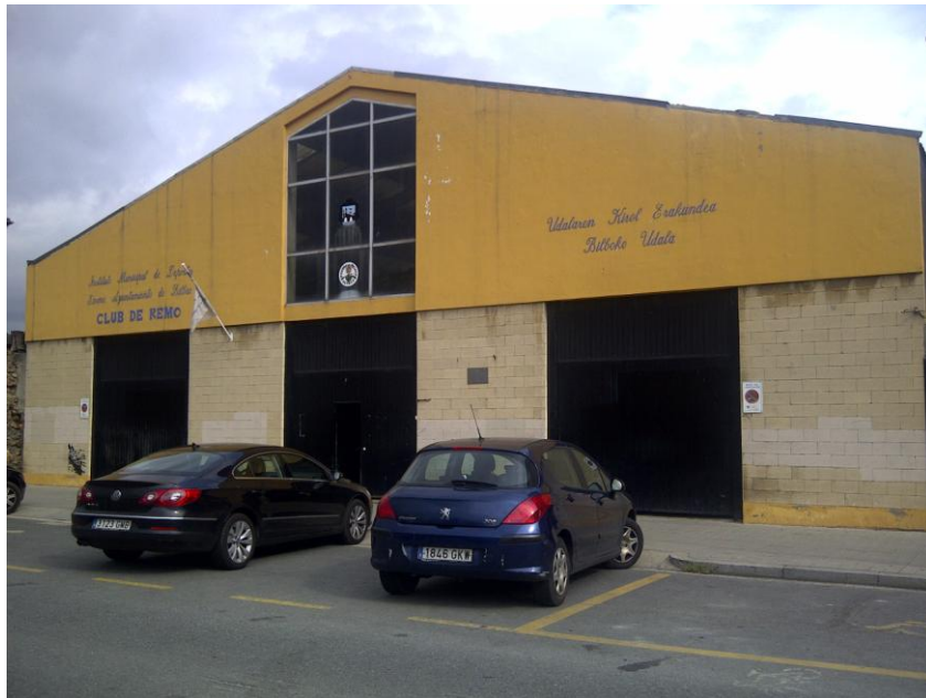
Vista de la fachada principal
