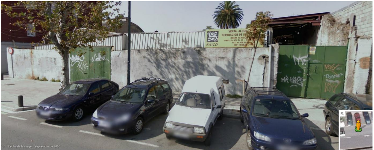
Vista de la fachada principal
