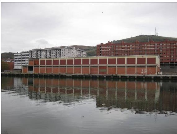
Zona superior: edificio 2
