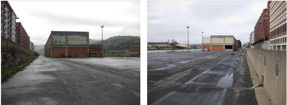
Ubicación del edificio desde sus accesos
