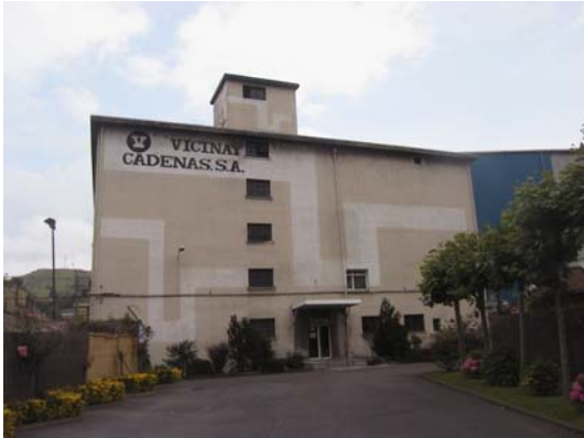
Fachada oficinas -A-
