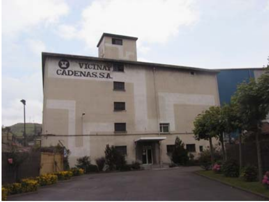
Fachada oficinas -A-
