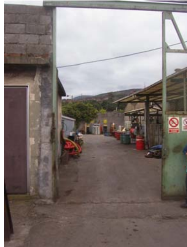
Almacén concretos -L-
