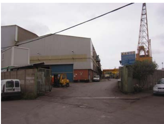
Fachada edificio -C-
