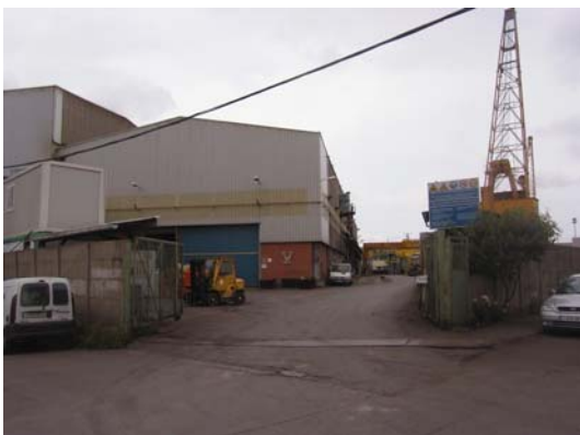
Fachada edificio -C-
