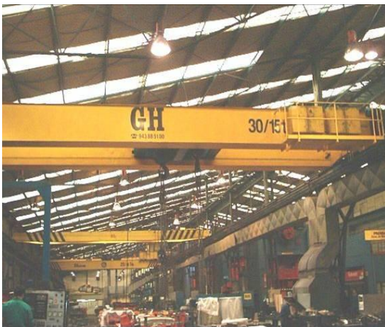
Fotografía general del interior de la nave izquierda (desde la fachada principal).
