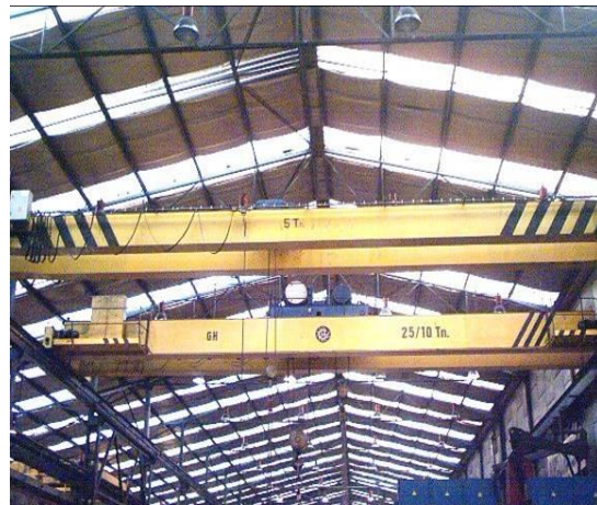
Vista general de la estructura y cubierta de la nave derecha, desde el interior de la misma.
